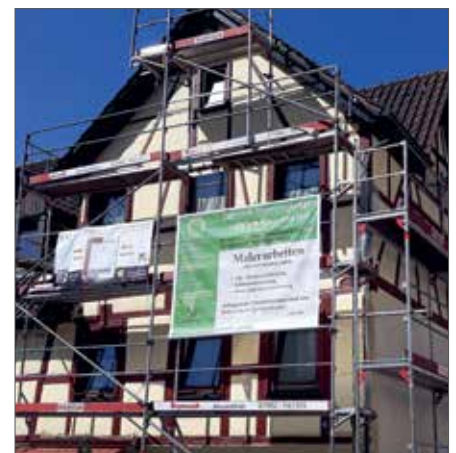
Projekt mit Außenwirkung: auch Renovierungsarbeiten zählen zum Portfolio
